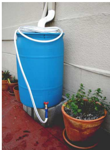
Rysunek 4. Zbieranie wody deszczowej (pokazuje propozycję wykonania małej beczki na wodę deszczową domowego wyrobu)
