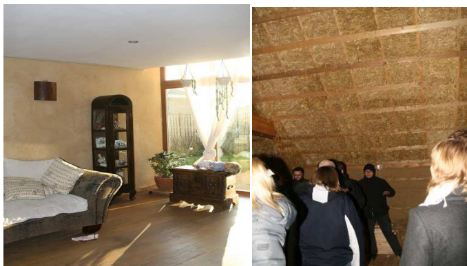
Rysunek 8. Budynki w technologii strawbale , Belgia 2009
